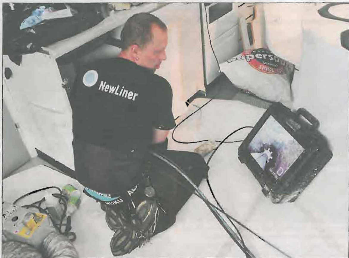
Benny Näsman tarkkailee monitorista viemäriputken sisäistä elämää.
